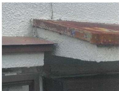
庇材の腐食
