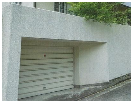
地盤面を構成している掘り込み車庫
